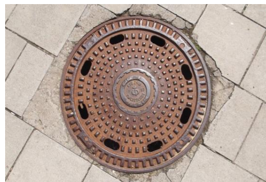
Tapa de alcantarilla de fundición, el mismo material con el que se fabrican los bloques
